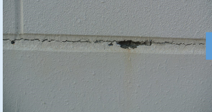
外壁の点検・ひび割れ補修
