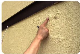
外壁の浮きやハガレをチェック。
